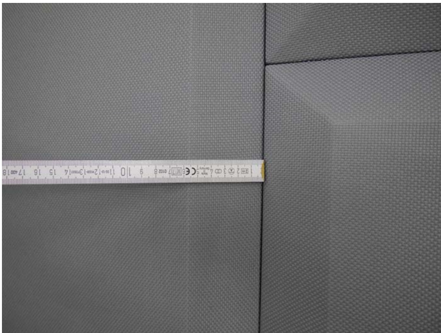
Abbildung B.2. Stumpfer Stoß der Wandpaneele zueinander.
